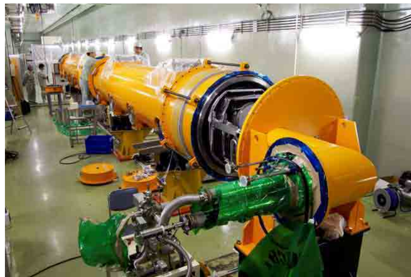
トンネル内での組立
