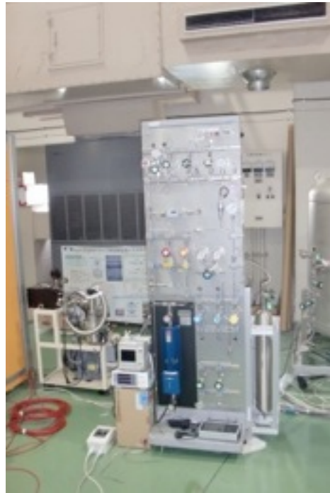
ガスハンドリングパネル
